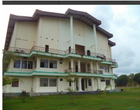
Gambar 8. Bagian Belakang Gedung C Unaya Sumber: Penulis
