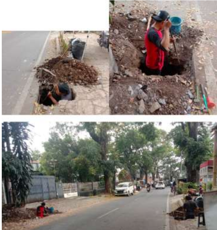
Gambar 4. Foto-foto Pengerjaan Saluran Air Bersih (Sumber: Dokumentasi Pribadi Panitia)
