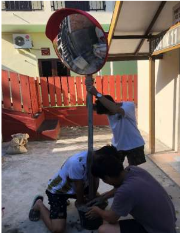
Gambar 3. Proses Pemasangan kaca cembung
