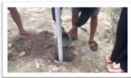
Gambar 8. Proses Pengecoran Pada Tiang Papan Nama Pasar
