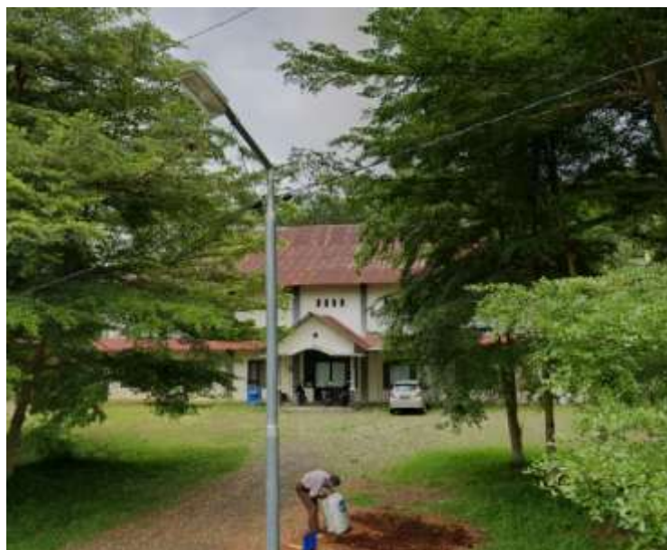
Gambar 1. Kondisi eksisting Balai RW di Desa Mergosari
